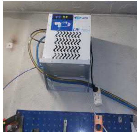
Ilmankuivaimen sähköistystä varastossa
