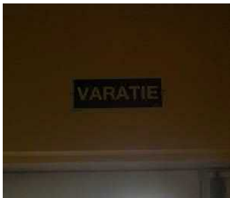
Jälkivalaiseva poistumistiekyltti oven yläpuolella
