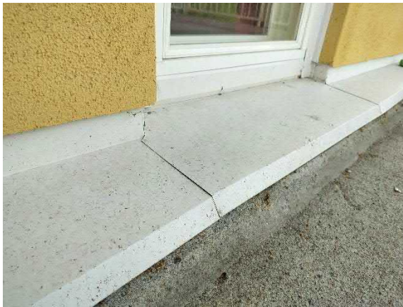
Alkuperäisen rakennusosan uusittuja ikkunoita
