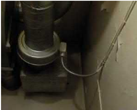
Kanavapuhaltimen sähköistystä varastossa
