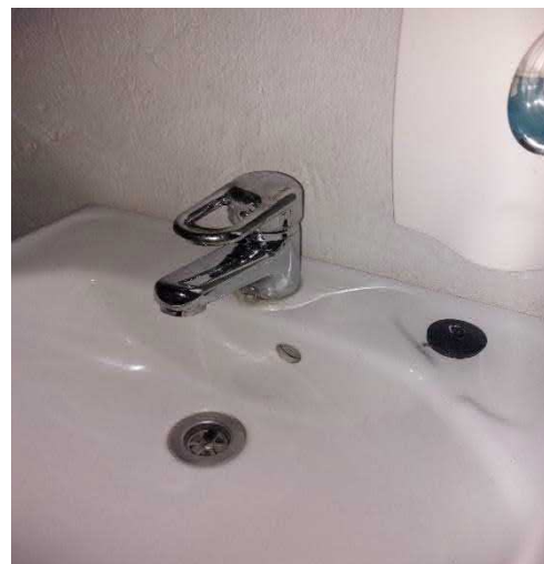
Uusittu pesuallashana wc:ssä.
