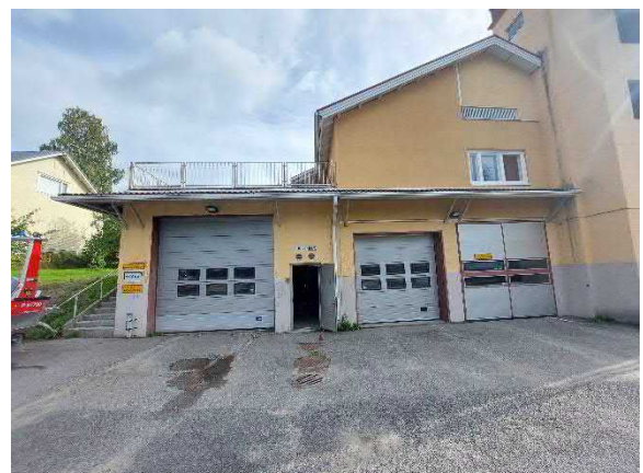
Yleiskuva autohallin ovista
