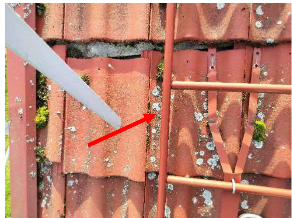
Rikkoutuneita kattotiiliä
