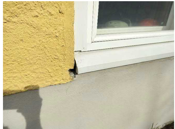
Alemman kerroksen vesipellin liitos
