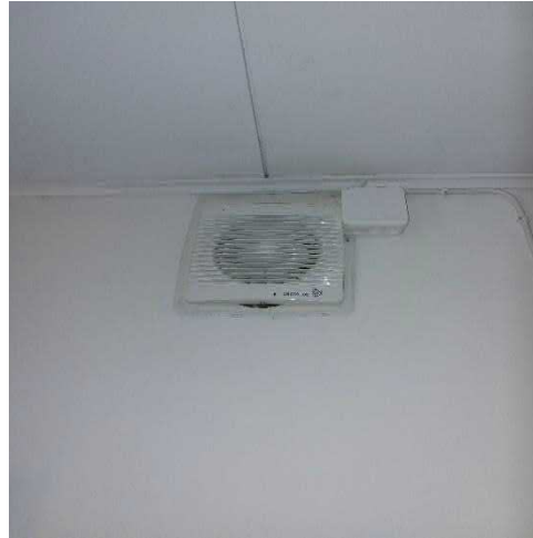
Wc-tilan ilmanvaihtoa tehostettu seinään asennetulla puhaltimella.
