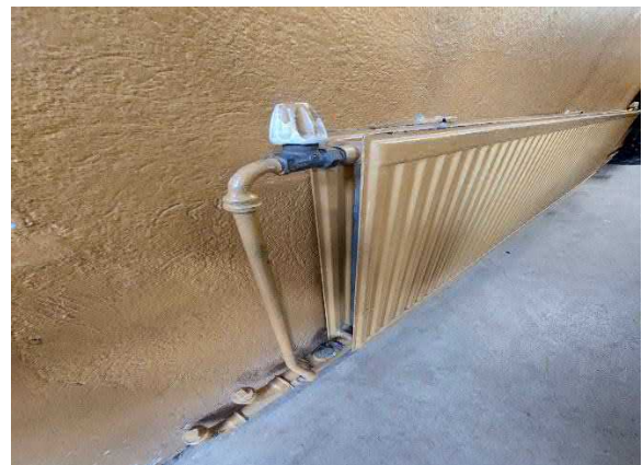
Patteriventtiili käsisäätöpyörällä.
