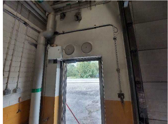
Autohallin korvausilmaventtiilit.
