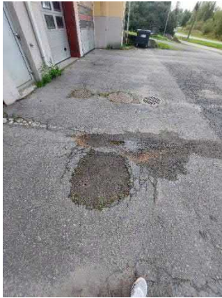
Yleiskuva alapihan ajoväylältä
