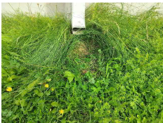
Etelänpuoleisen lappeen sadevedenpoisto
