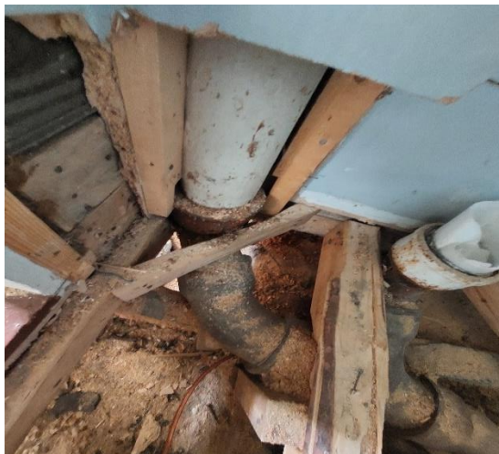
Alkuperäinen valurautaviemäri wc:n lattiassa.
