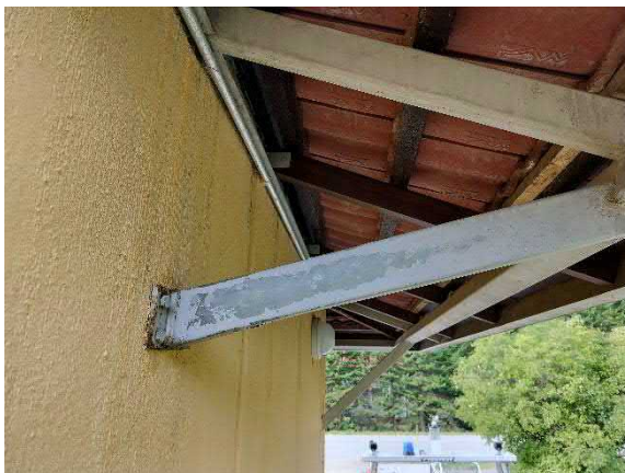
Kondensoituneen veden vaurioittama teräsrakenne
