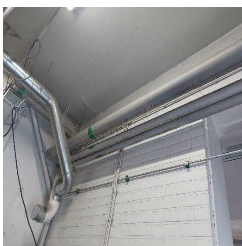
Pakokaasunpoistokanava laajennusosalla.
