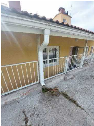
Kattokaivo laajennusosan katolla
