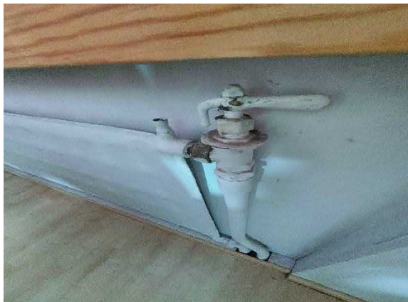
Alkuperäinen patteriventtiili.
