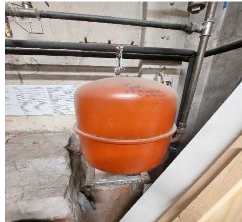
Paisunta-astia lämmönjakohuoneessa.
