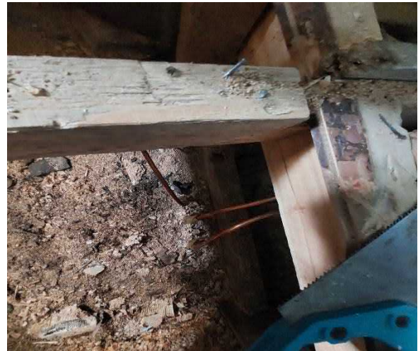
Alkuperäiset kupariset käyttövesijohdot wc:n lattiassa
