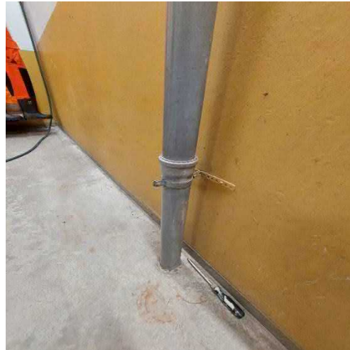
Muovinen sadevesiviemäri kiinteistön laajennusosalla.
