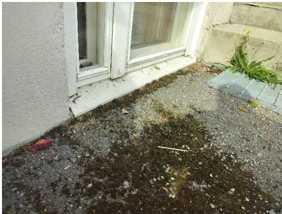
Yläpihan sisäänkäynnin viereinen ikkuna
