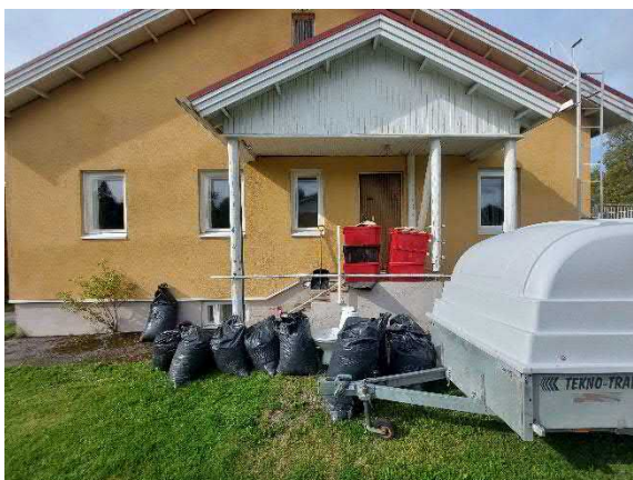
Yläpihan sisäänkäynnin viereinen ikkuna
