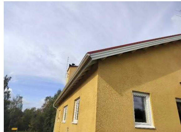
Yleiskuva rakennuksen kaakkoiskulmalta
