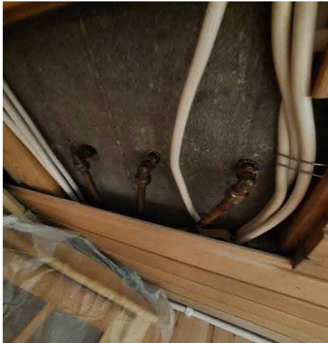
Alkuperäisiä vesijohtoja seinän sisällä.
