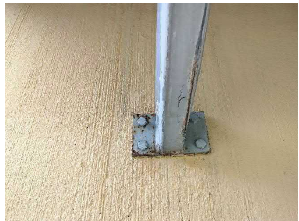
Kondensoituneen veden vaurioittama teräsrakenne
