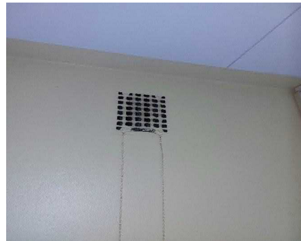
Painovoimainen poistoilmasäleikkö.
