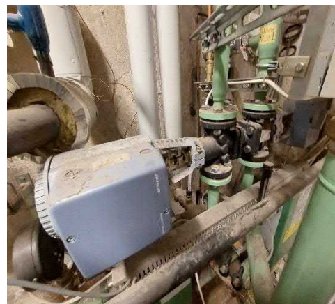
Lämmitysverkoston säätöventtiili.
