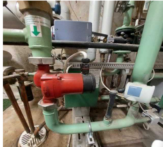
Siemens oy:n valmistama lämpötila-anturi ja toimilaite.
