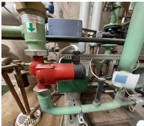
Lämmitysverkoston kiertopumppu.
